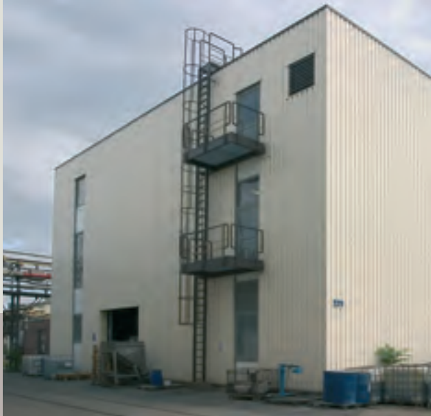
Planta de sulfato estanoso en Mannheim ...
