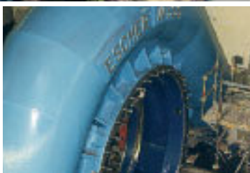
Recubrimiento interior resistente a la abrasión de una turbina de bomba con PROTEGOL®UR 32-55, Parque energético de Vattenfall, Geesthacht
