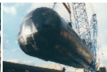
Tanques: revestimento exterior de um tanque para a indústria química
