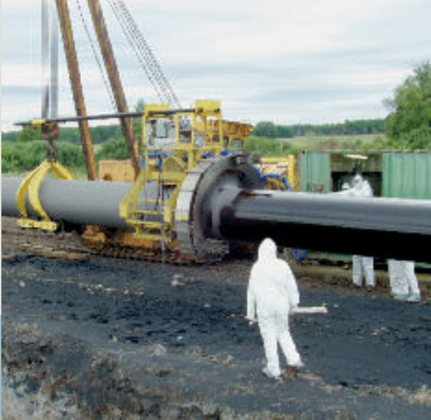
Reparação de tubulações/pipelines com revestimento PROTEGOL®UR 32-55 – acima da vala – com anel automático de aplicação e três cabeças de injeção oscilantes na região de Tscheljabinsk/Sudeste dos Urais (Foto: Incal Pipeline Inc.)
