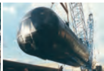
Tanks: Außenbeschichtung eines Tanks für die chemische Industrie
