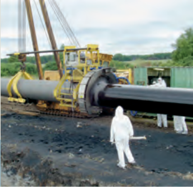
Pipelinesanierung mit PROTEGOL®UR Beschichtung 32-55 – over the ditch – mit automatischem Applikationsring und drei oszillierenden Spritzköpfen in der Region Tscheljabinsk/Südost-Ural (Bild: Incal Pipeline Inc.)
