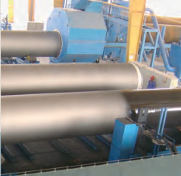
Online-Beschichtung von Rohren mit unterschiedlichen Nennweiten: Strahleinheit/Pufferzone/Beschichtungsstation für Einzelrohre
