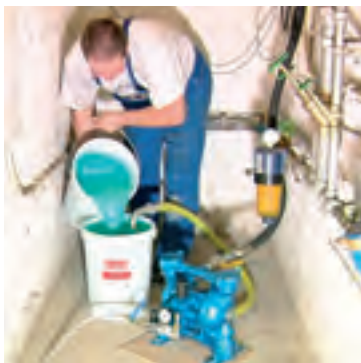
Befüllen einer Gasleitung mit PRODORAL® R 6-1
